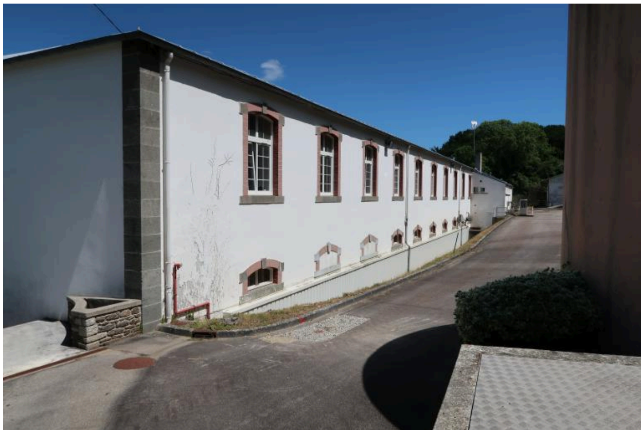
Vue générale depuis l'ouest-sud-ouest : élévation postérieure sud (état en 2022)
