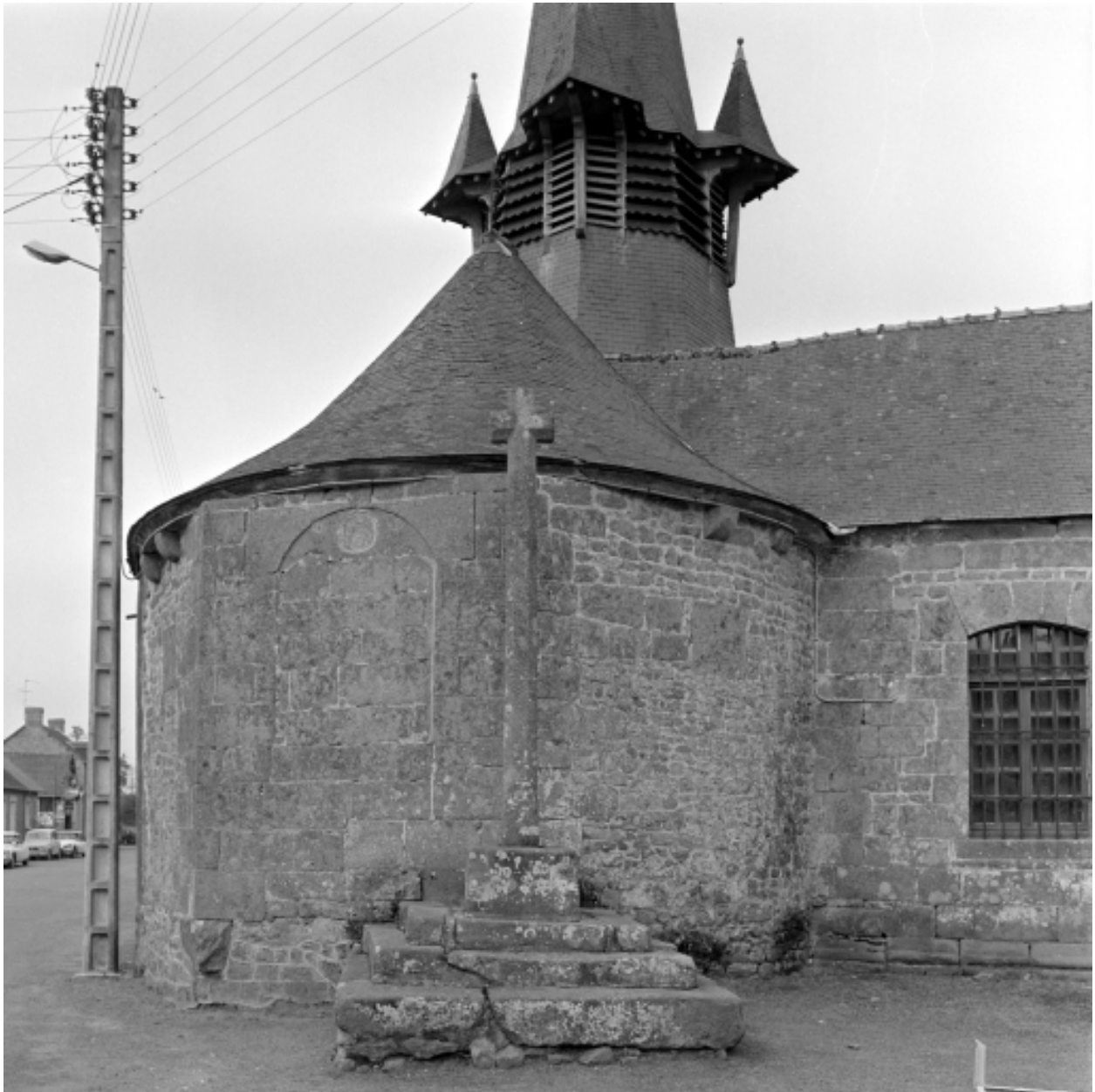
Elévation est : vue générale
