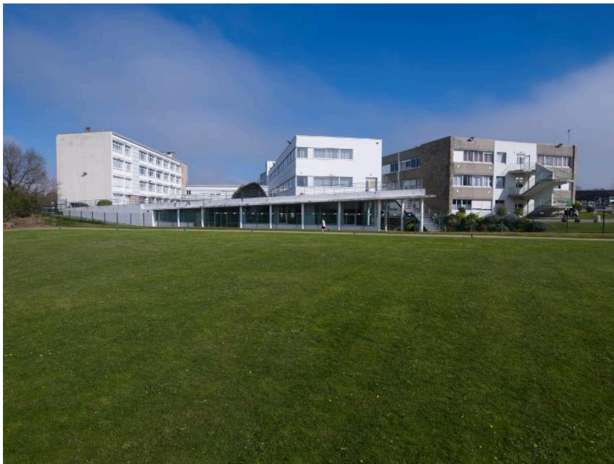
Vue générale prise du sud.
