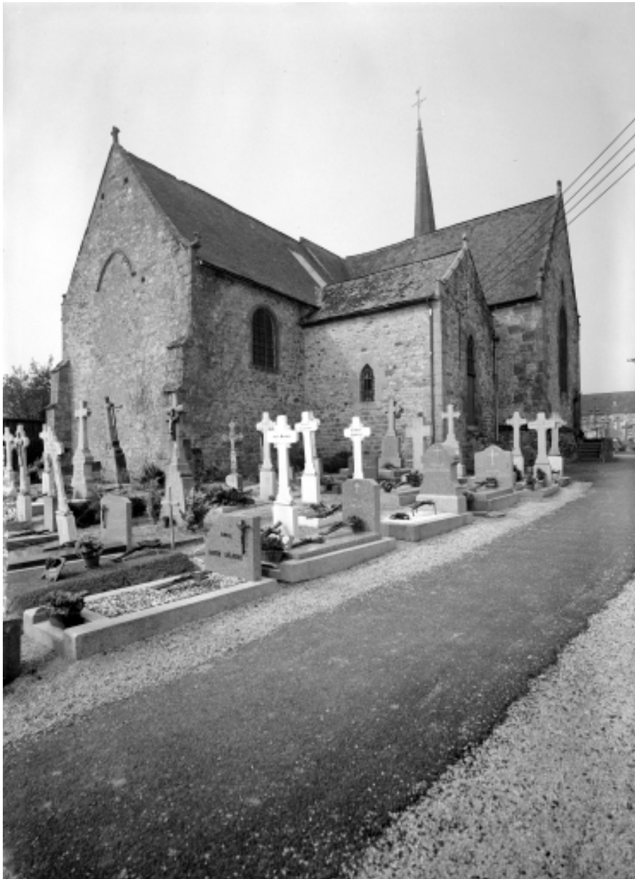
Elévation Nord-Est : vue générale
