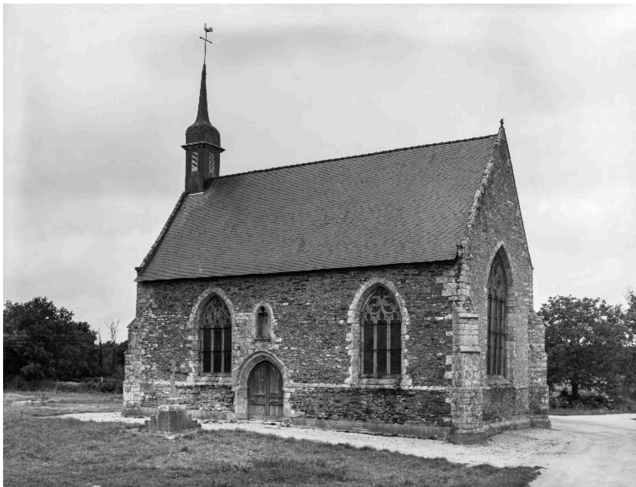
Chapelle vue depuis le sud (état en 1984)
