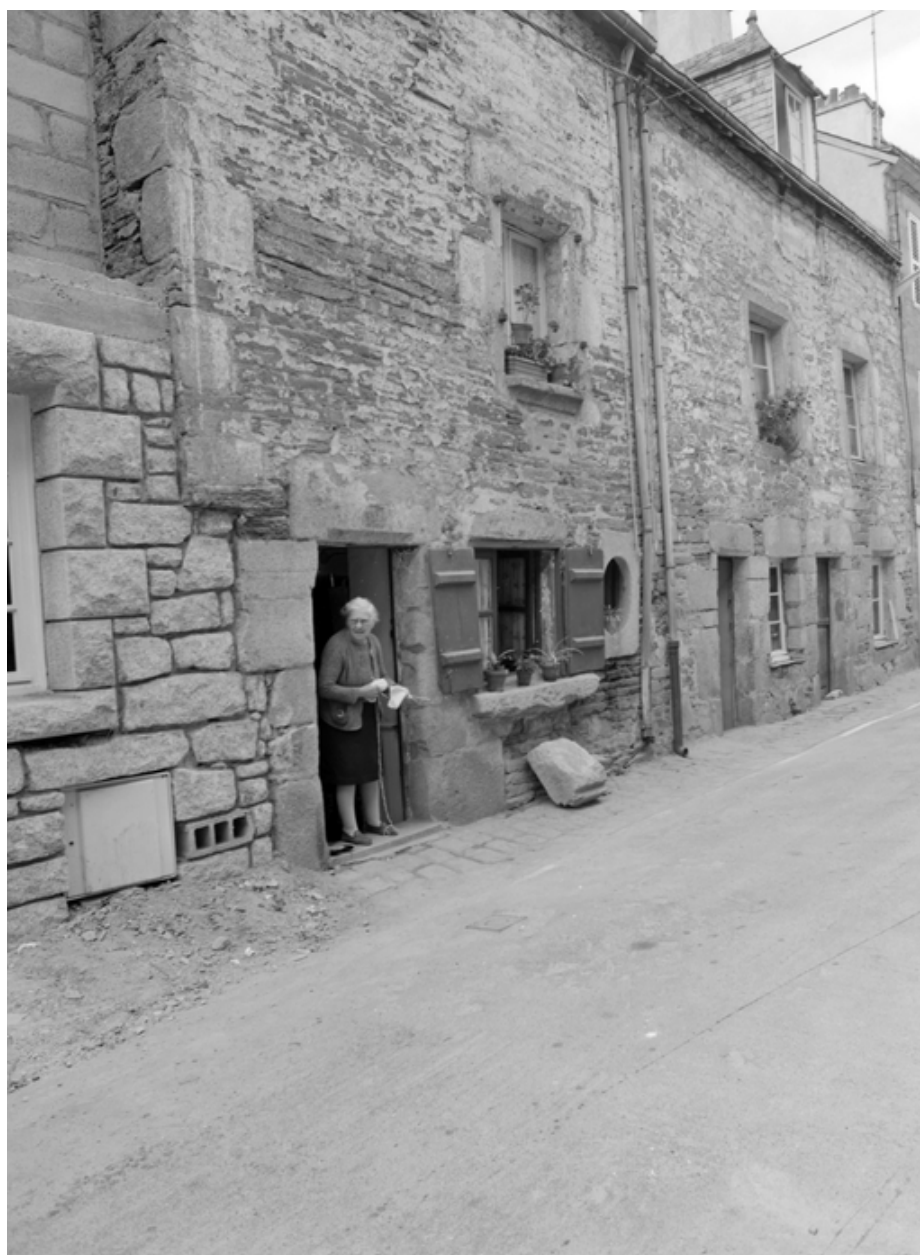
14-16 rue des Forges, vue générale des façades.
