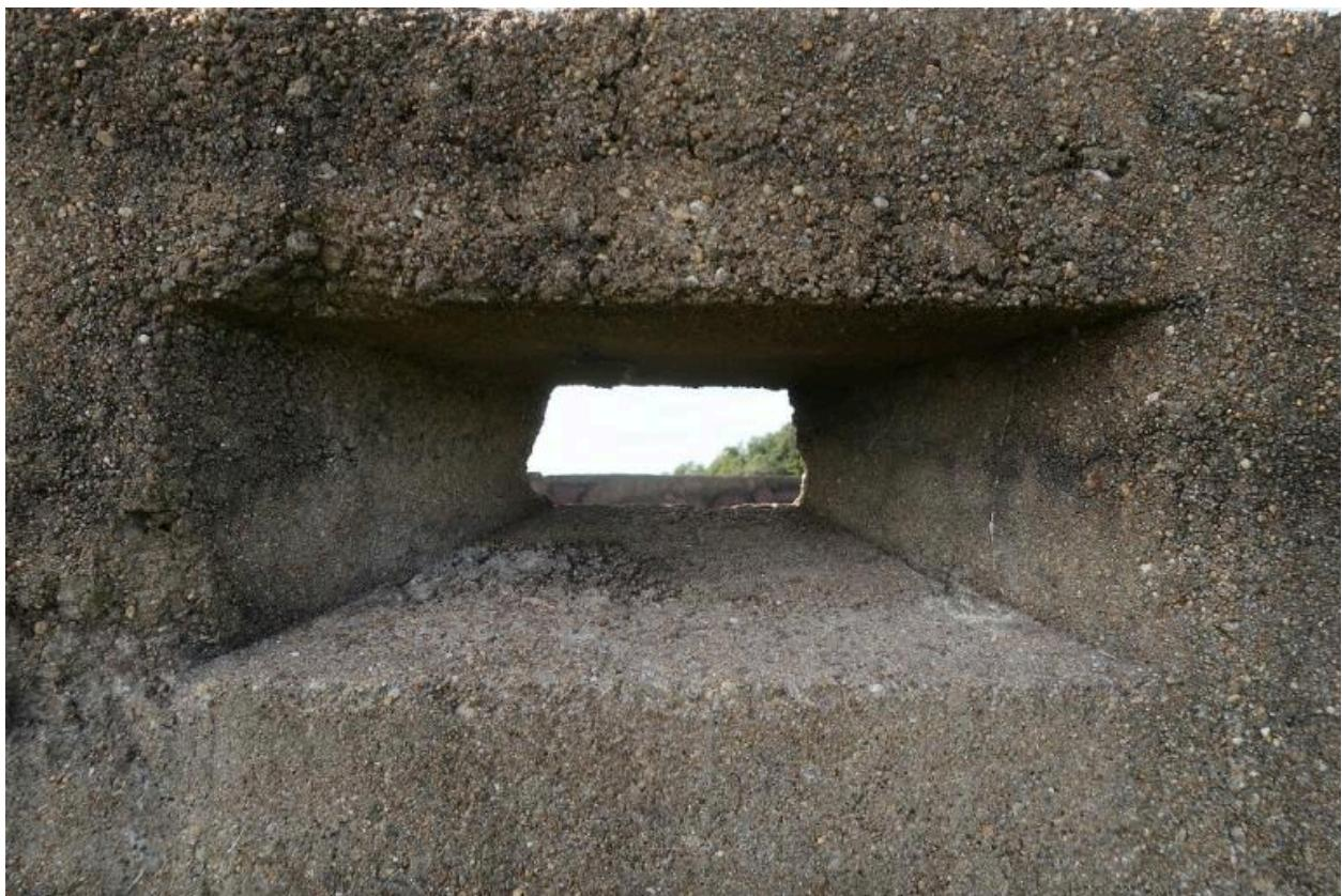
Vue du bunker-cuve sud pour canon antiaérien : ouverture de tir axiale dans l'élévation est. Les élévations est, sud et ouest sont percées d'une ouverture de tir axiale pour la défense rapprochée en cas d'attaque terrestre
