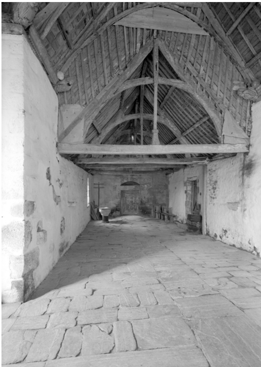
Intérieur : vue du revers de la face ouest
