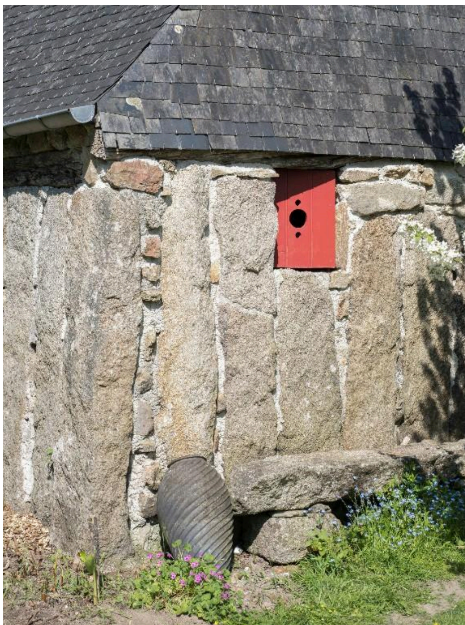
Vue de détail de la mise en oeuvre de l'angle avec orthostates.
