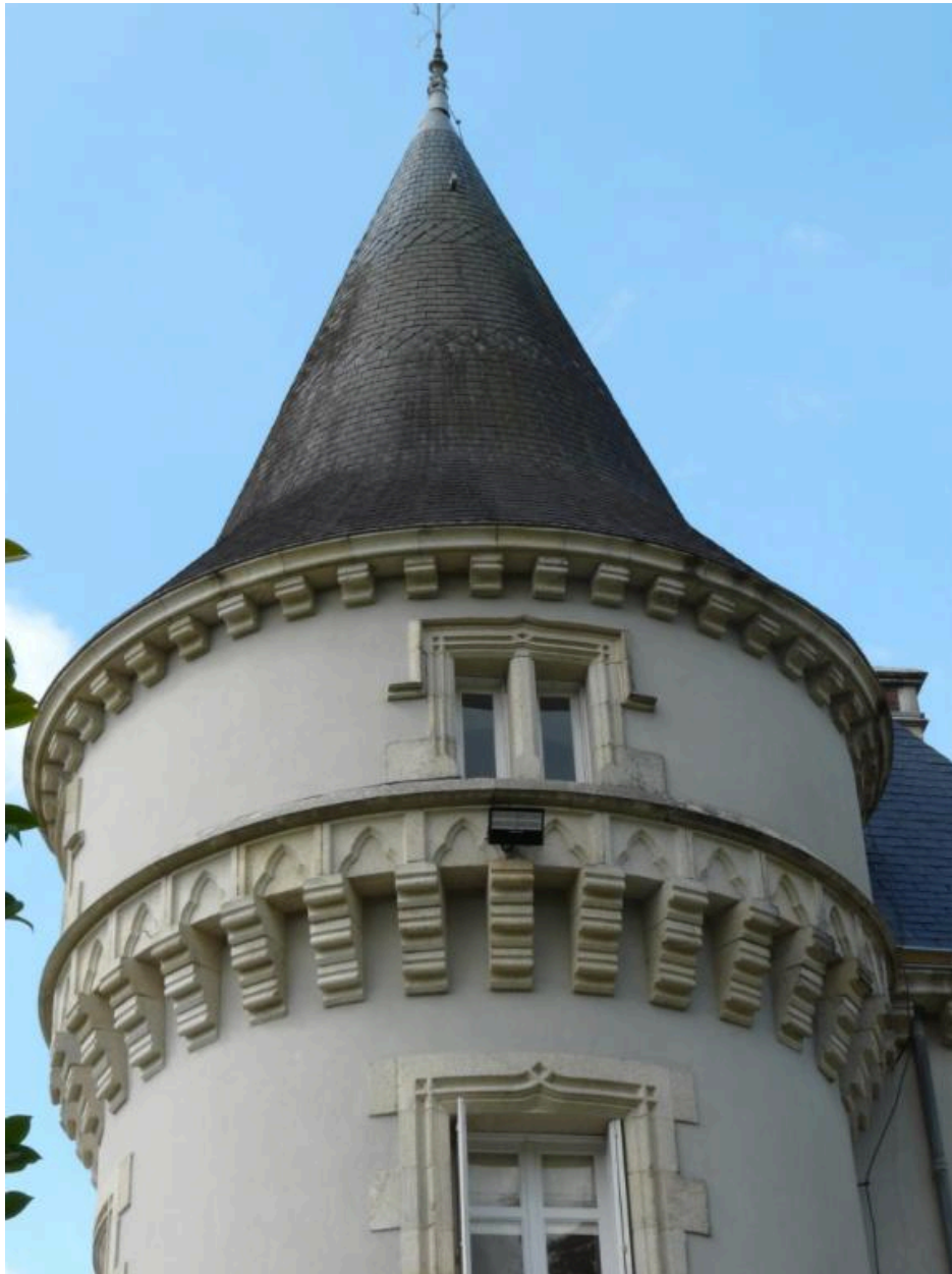
Tour d'angle, machicoulis et toiture en poivrière
