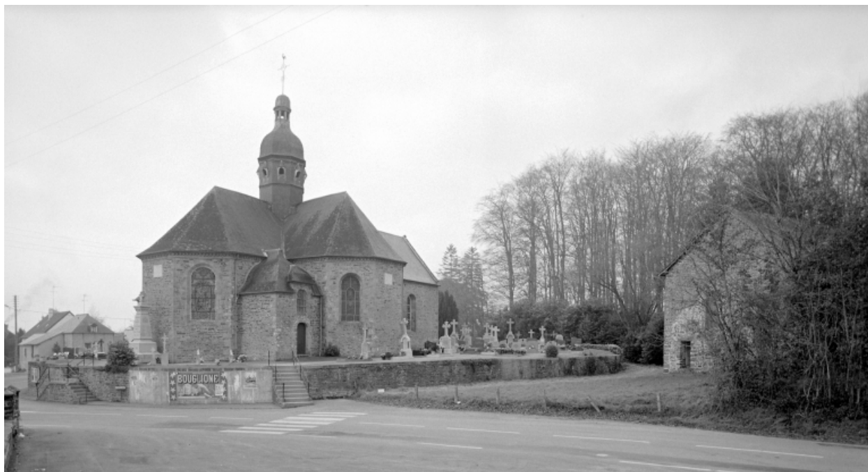
Elévation Nord-Est : vue générale
