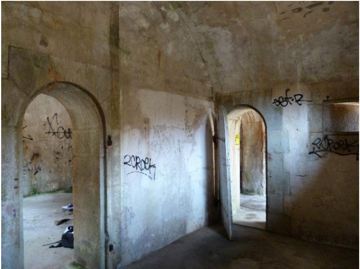
Archipel de Glénan, batterie de Penfret, corps de garde crénelé, chambres du chef de poste et du gardien.
