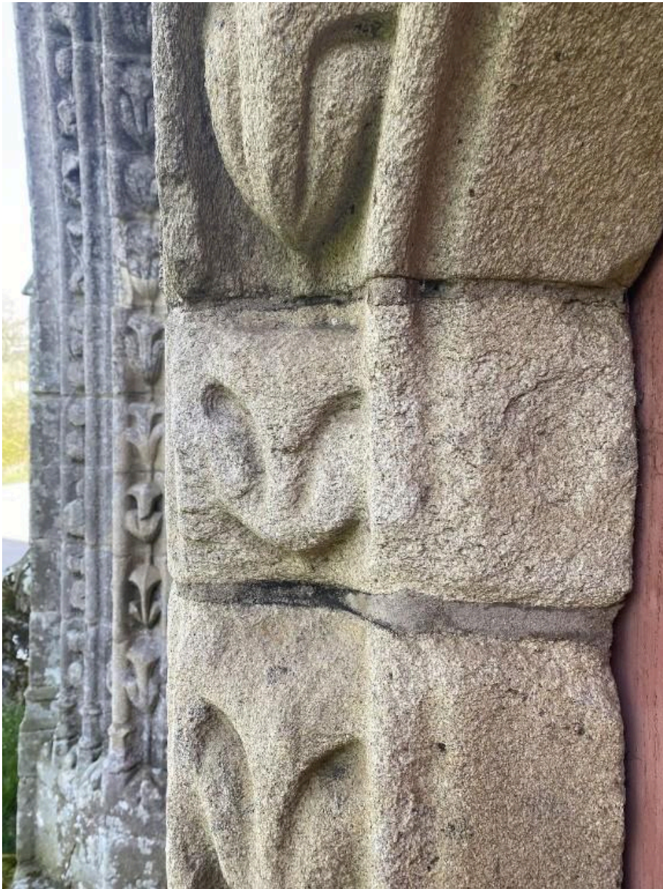
Portail ouest, détail
