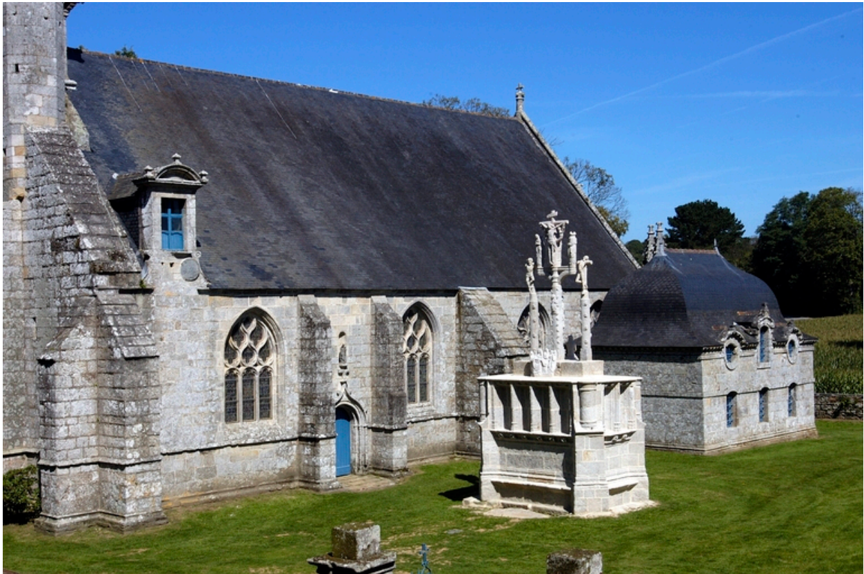
Vue générale de la chapelle et du calvaire (classement par arrêté du 9 mai 1914) ; la sacristie en arrière-plan
