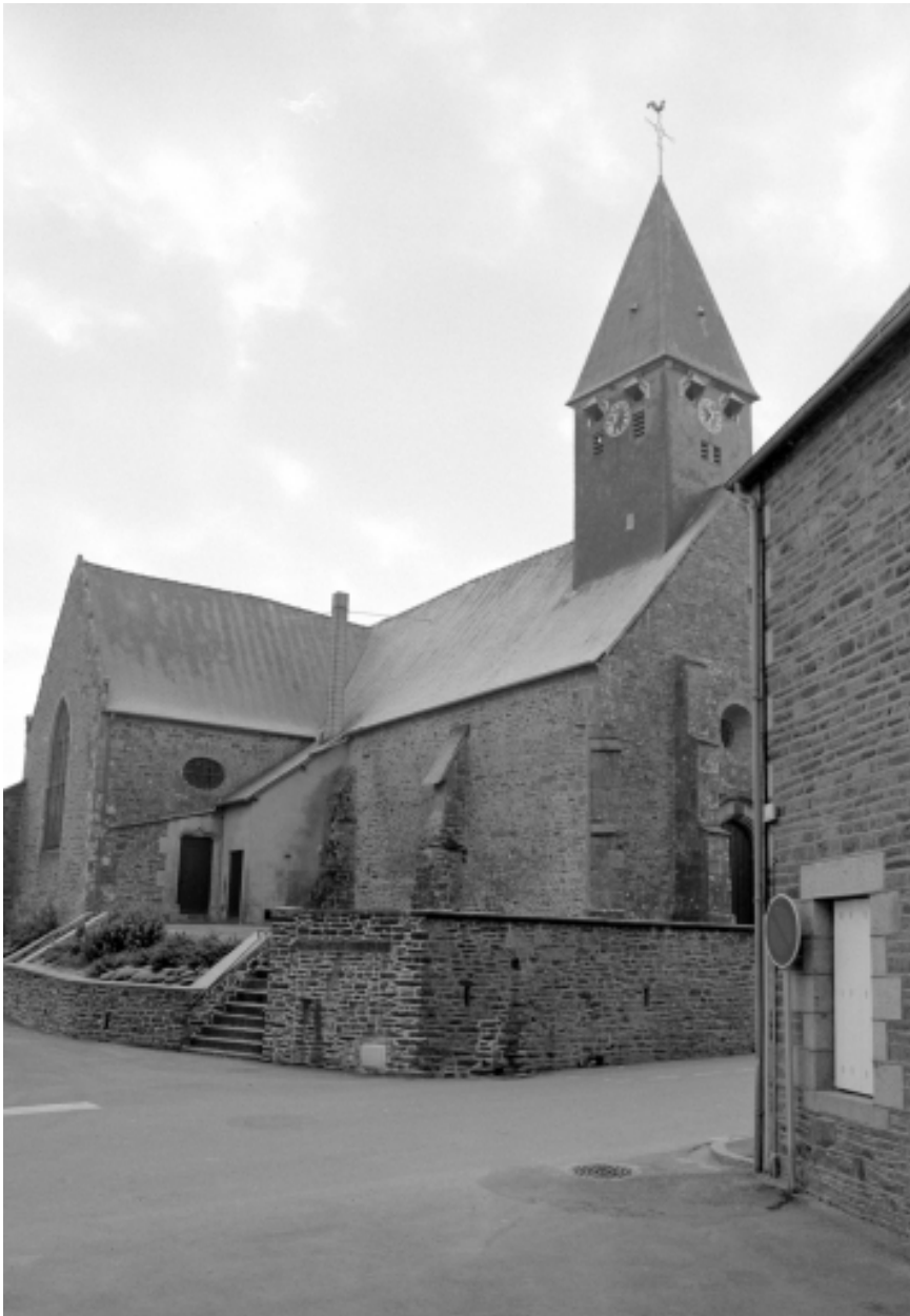
Elévation Nord-Ouest : vue générale
