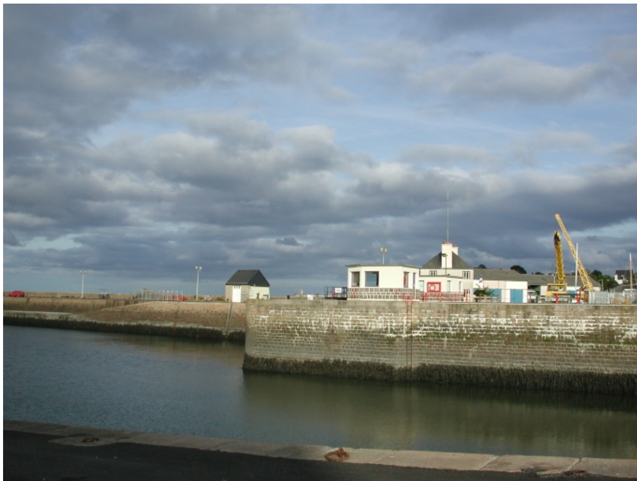
Vue de la jetée de Kernoa et des nouveaux quais de l'écluse depuis la cale de Bréhat
