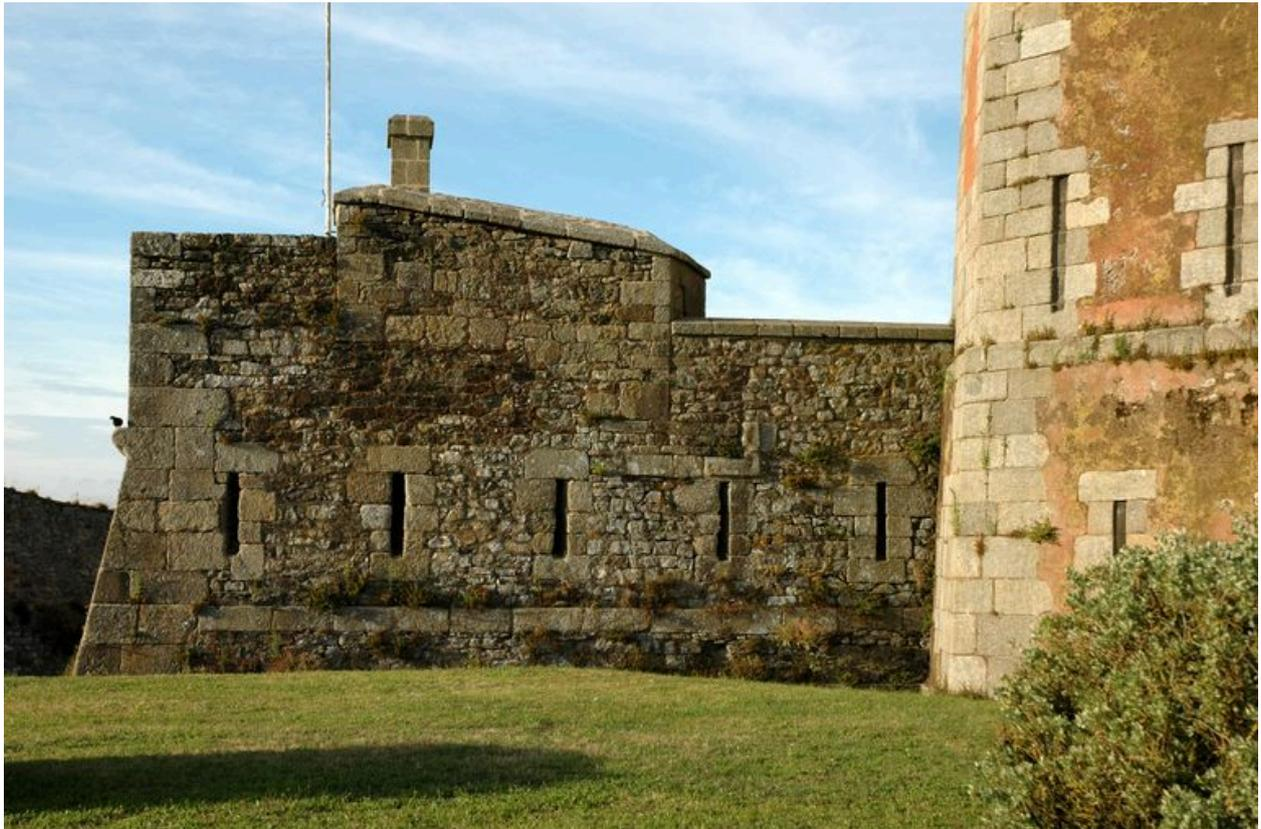
Vue du four à boulets depuis l'extérieur (période révolutionnaire). Un corps de garde identique à celui du pont-levis se dressait à la place du four à boulets en couronnement de la galerie de fusillade
