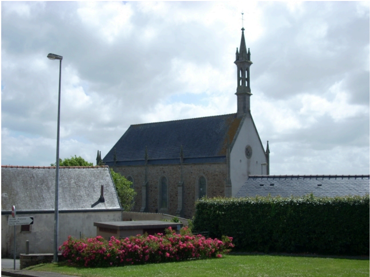
Plouider, chapelle Notre-Dame-des-Malades : vue de situation depuis le nord-ouest
