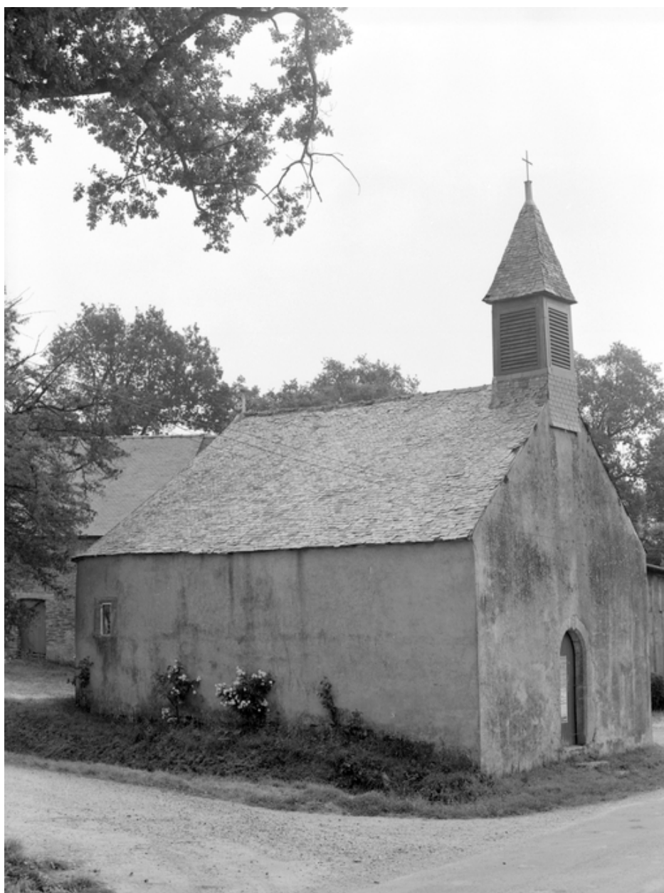
Chapelle vue nord-ouest (état en 1984)
