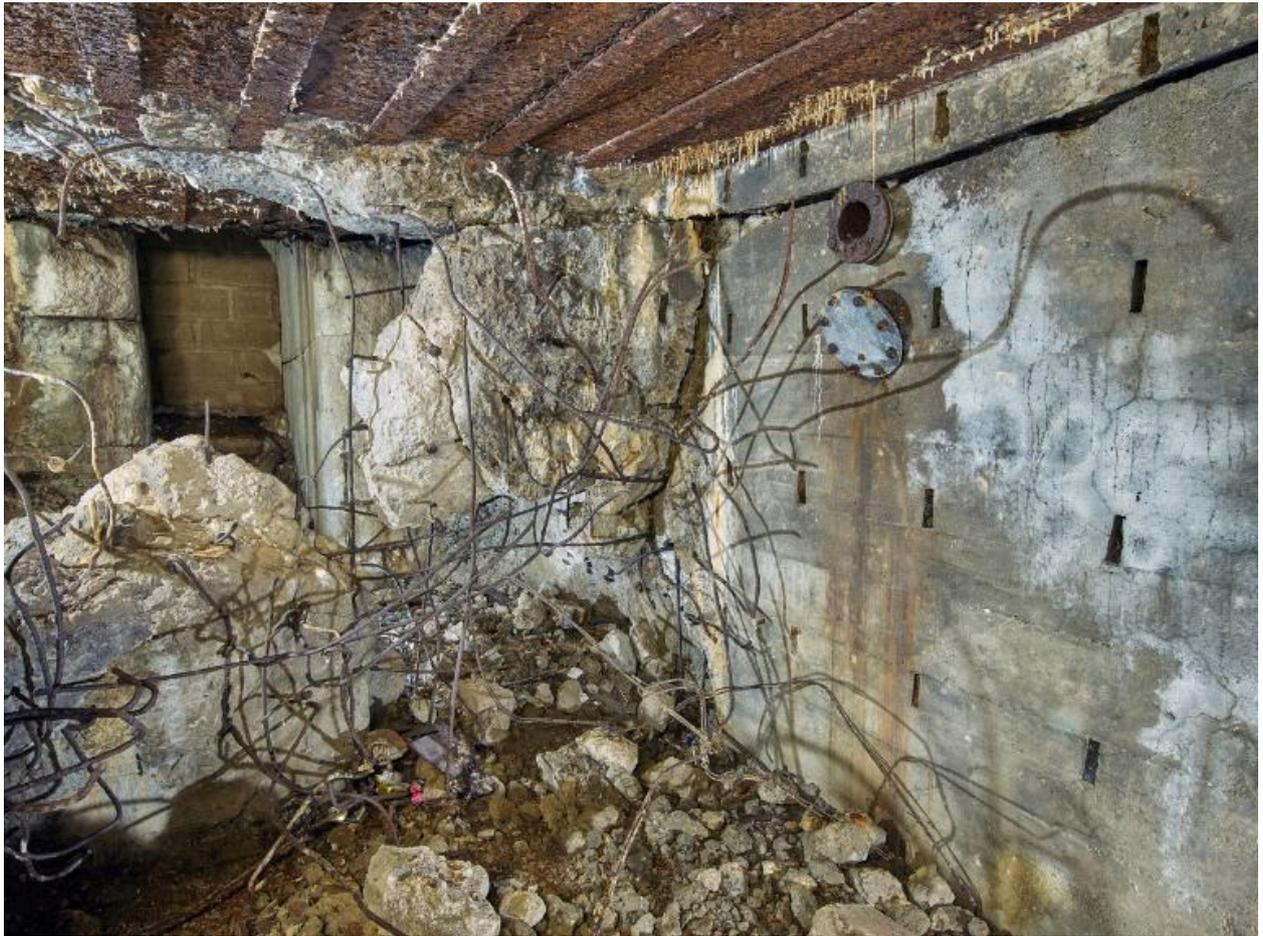
Vue de la pièce de vie - chambre Nord : résultat de l'explosion sur le mur du sas, fers à béton entrelacés. Dans le mur, conduit de cheminée du poêle et conduit de ramonage (fermé par un couvercle boulonné)
