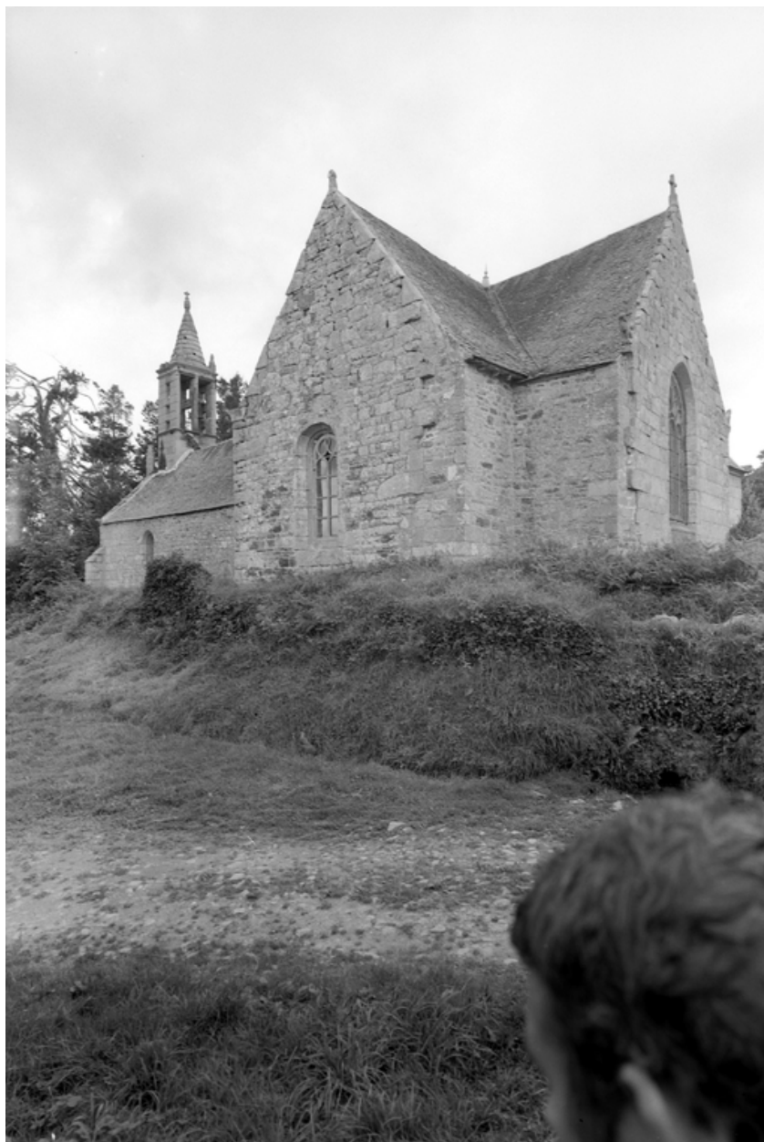
Vue d'ensemble sud-est
