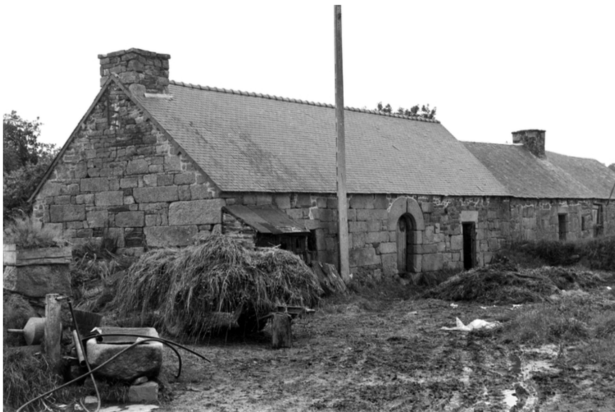
Maison (Kermarck) : vue générale de la face est de l'alignement
