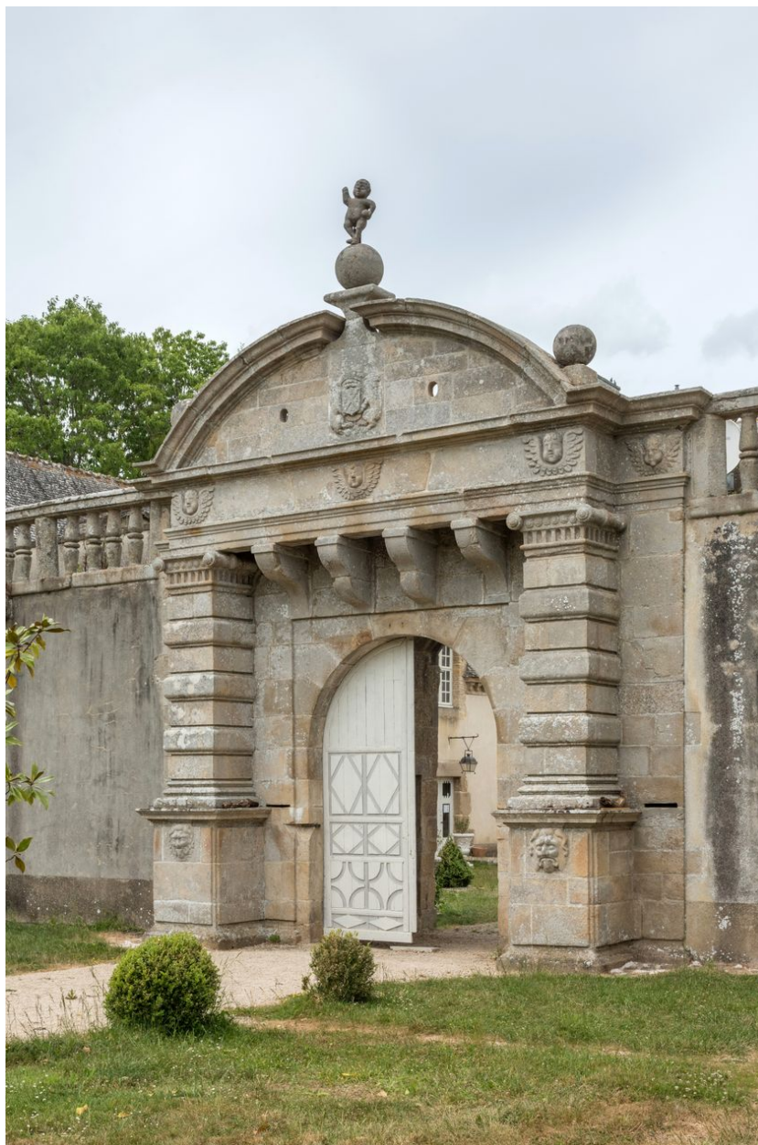
Corps de passage au sud, vue d'ensemble
