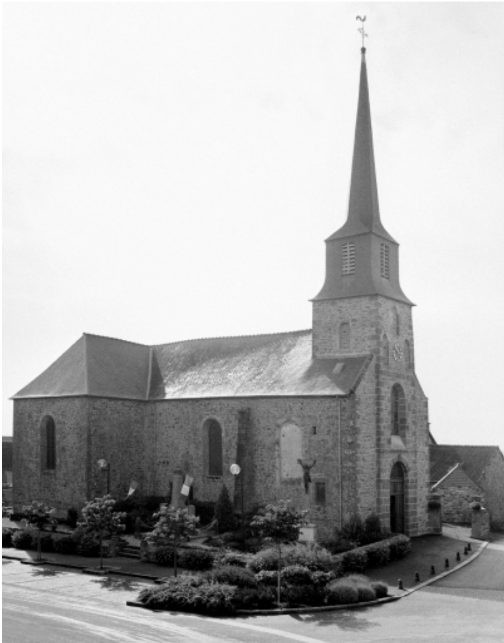
Elévation Nord : vue générale
