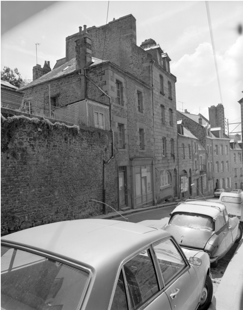
21 rue de la Pinterie, vue générale nord-est.
