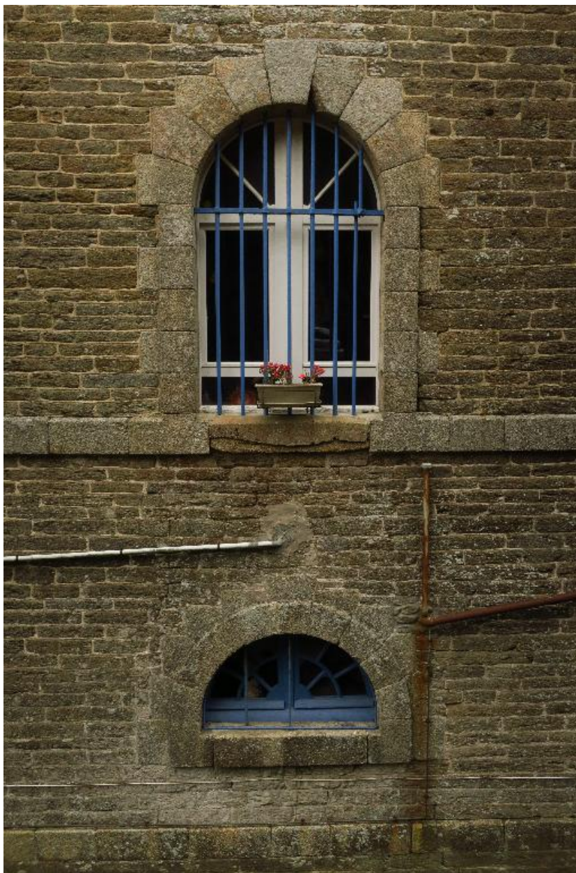
Groix, fort dit Fort Surville, caserne à l'épreuve, détail de la façade.
