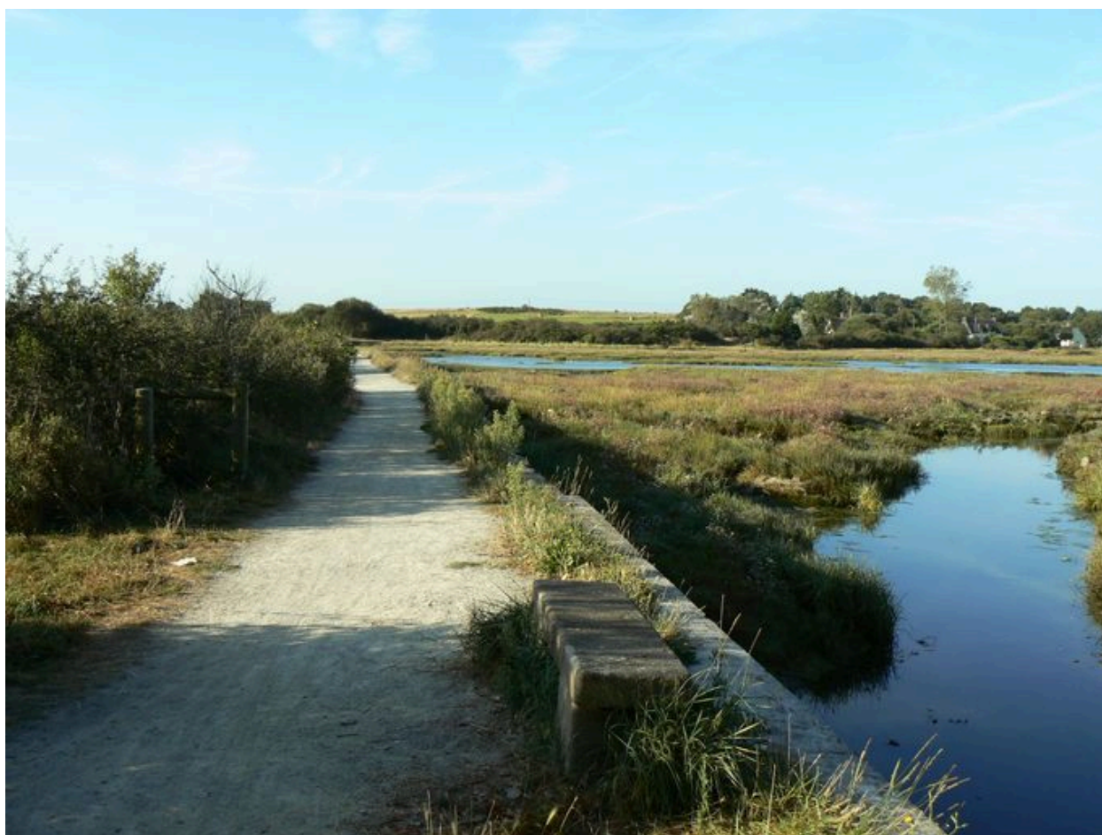
Digue-route dite le Pont Lisse
