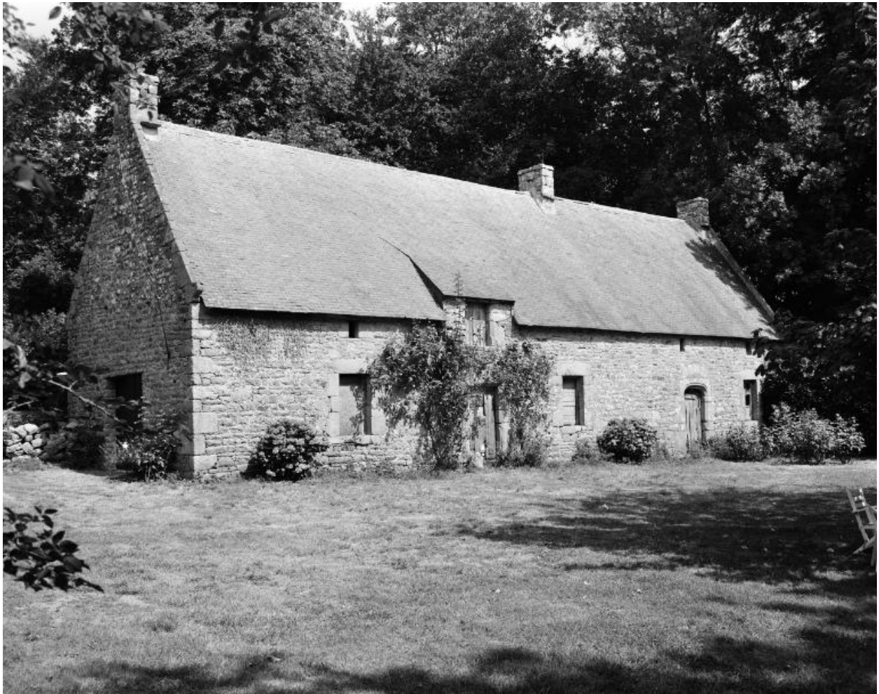
Ferme, vue générale sud.
