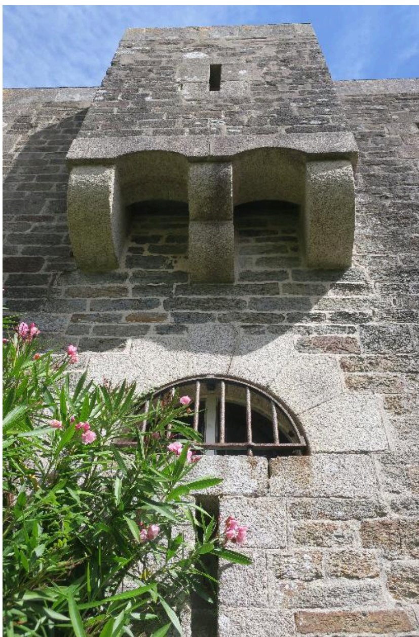
Le Palais, Port Larron, corps de garde crénelé, bretèche.
