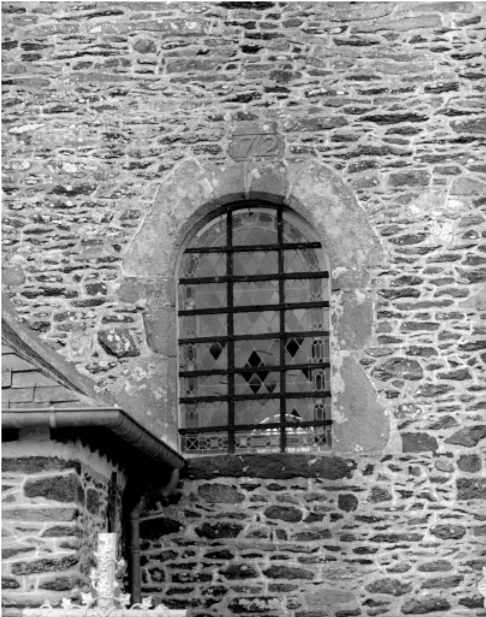
Elévation Sud, fenêtre datée 1712 : vue générale
