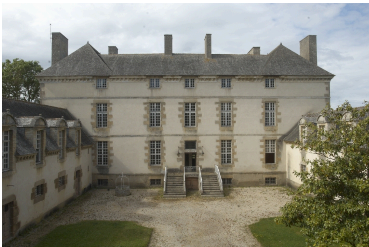
Château : vue générale du corps principal
