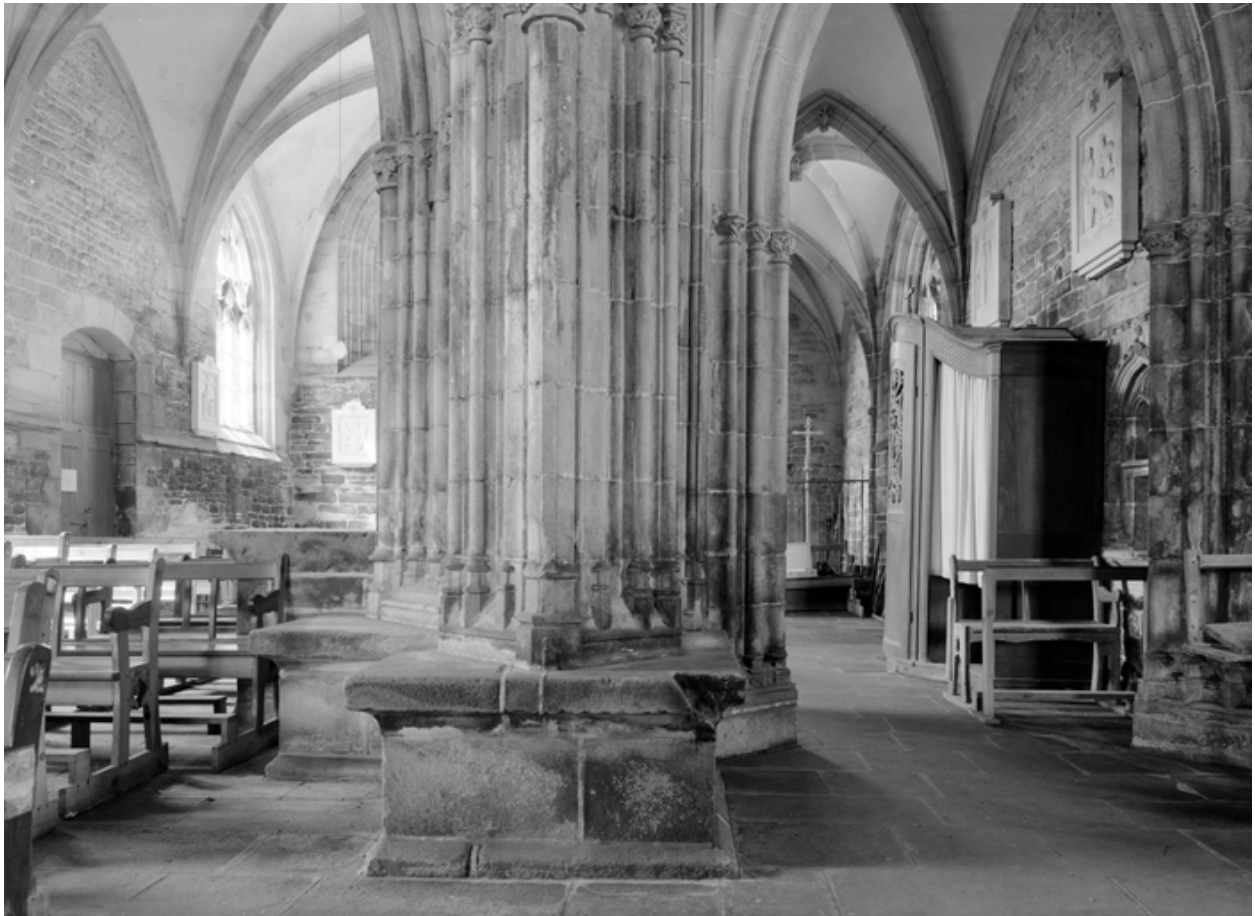
Pilier massif nord-ouest, bases de colonnettes.
