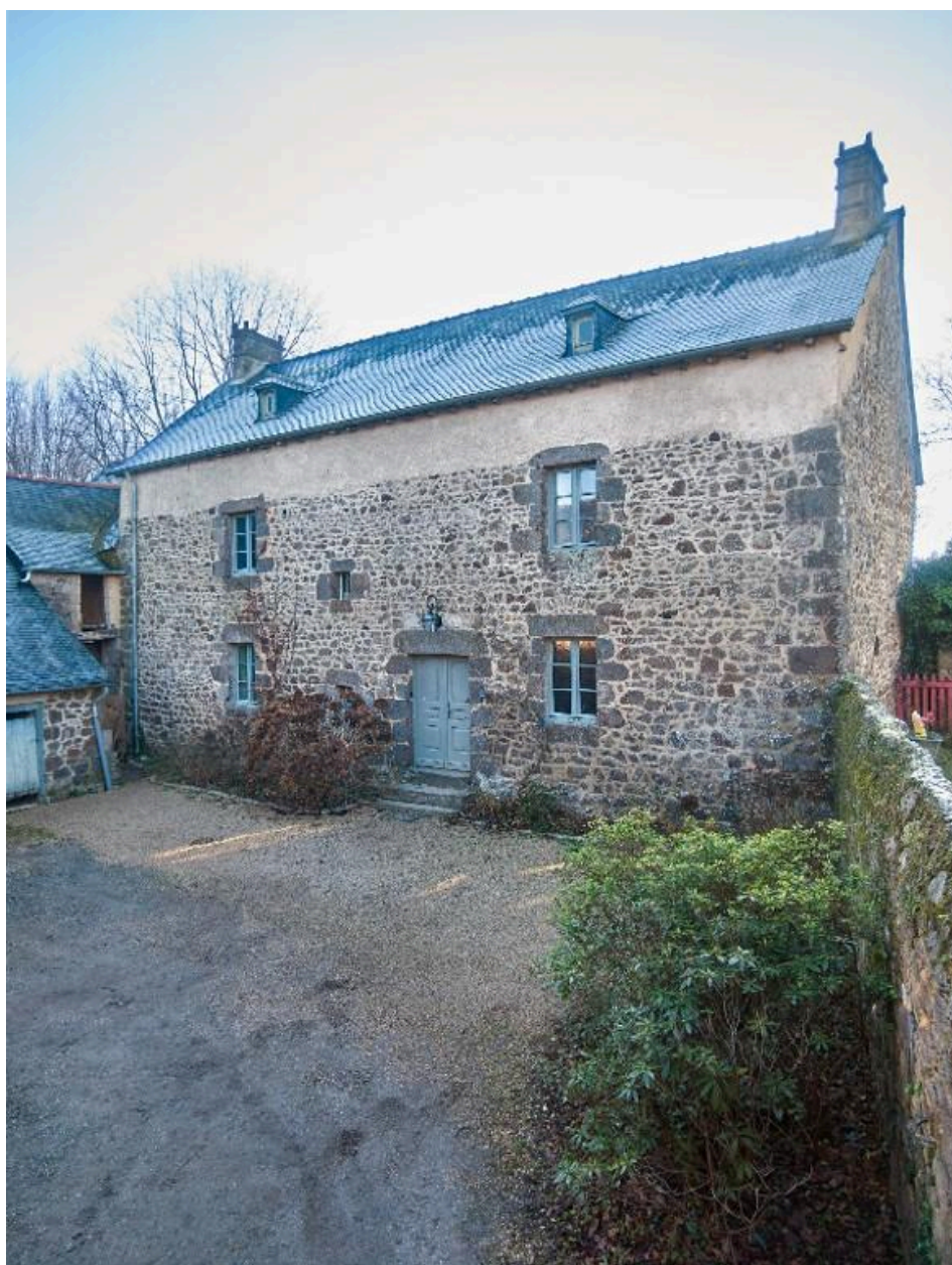
Logis. Vue générale nord-ouest
