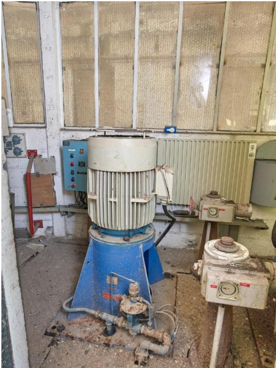
Vue du local des pompes nord situé entre les alvéoles A et B : pompe 2, avec vannes et tableau électrique de commande
