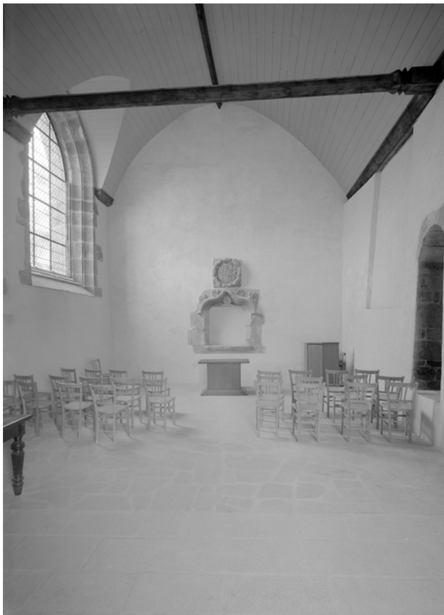
Chapelle, deuxième niveau, vue vers l'est.
