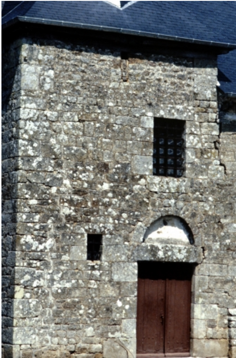
Façade sud, détail de la tour.
