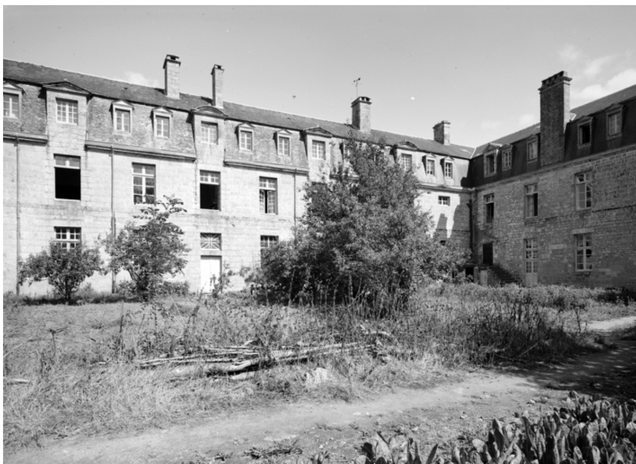
Corps de bâtiment C, façade sud et aile sud (1965)
