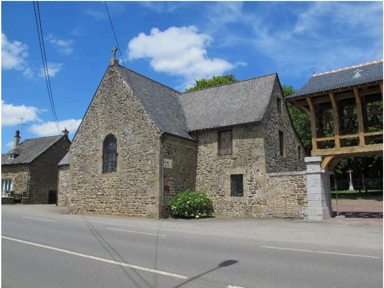
Vue générale : côté Sud-Est (état actuel)
