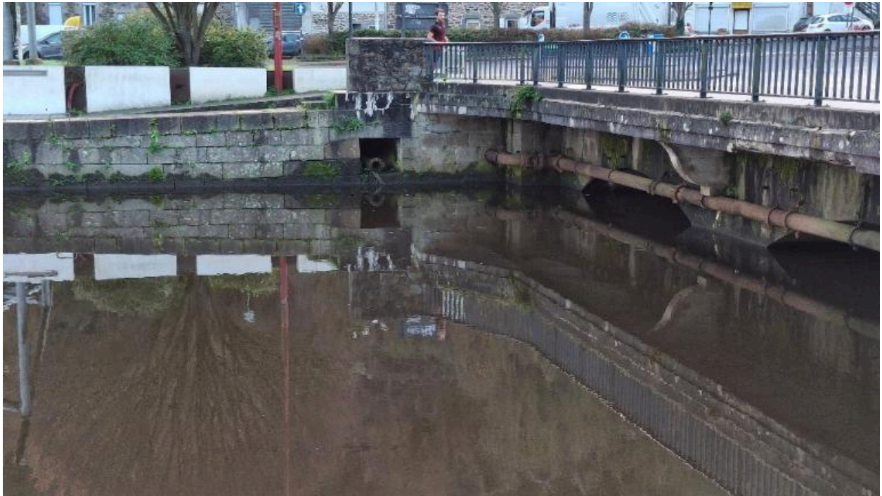
Le pont-de-pierre : tablier et culée rive droite
