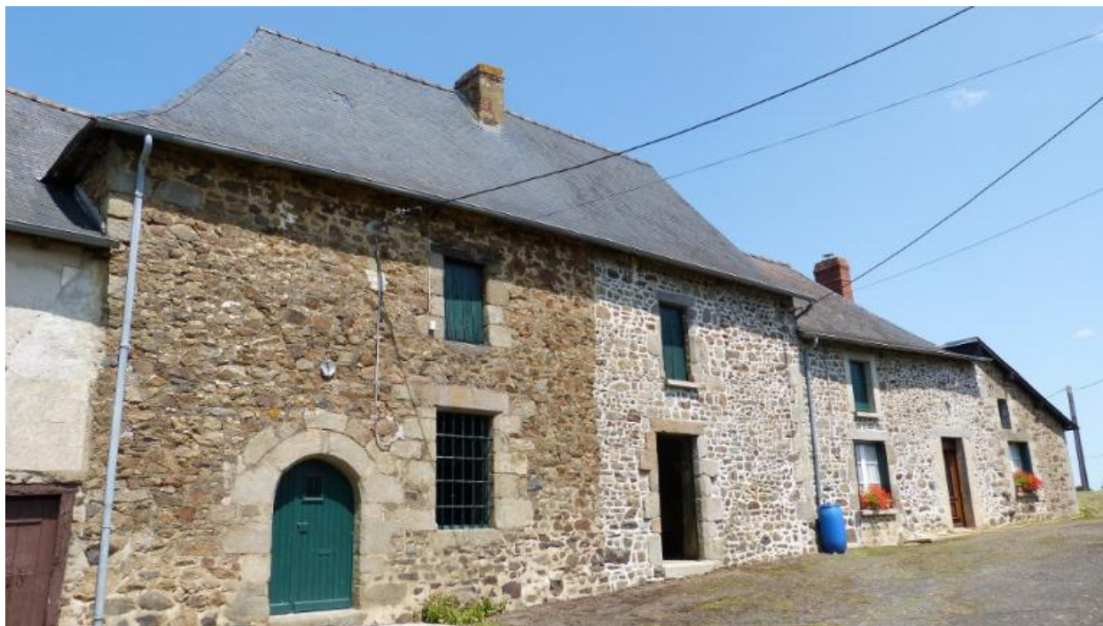
Vue générale sud, Ferme, Belême (Hédé-Bazouges)
