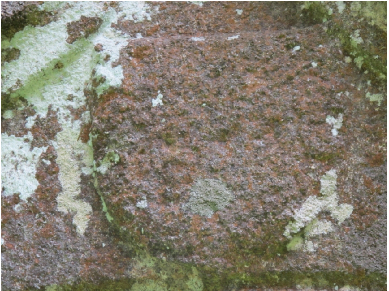
Détail d'un écu sur le linteau de la fenêtre, façade postérieure
