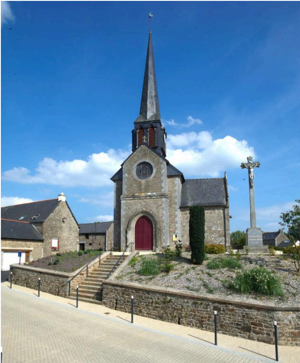
Elévation Ouest, le portail : vue générale
