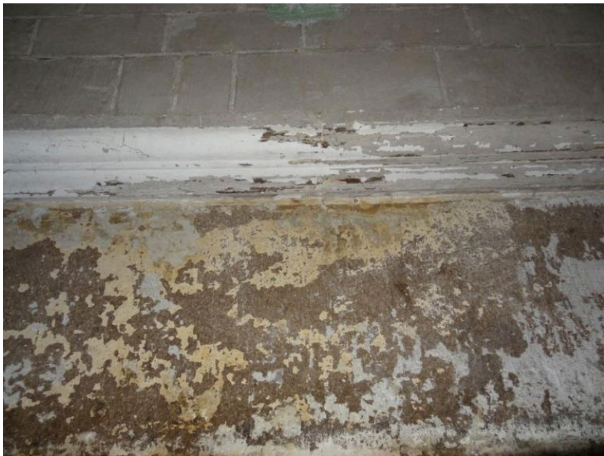
Détail de la corniche de la cheminée
