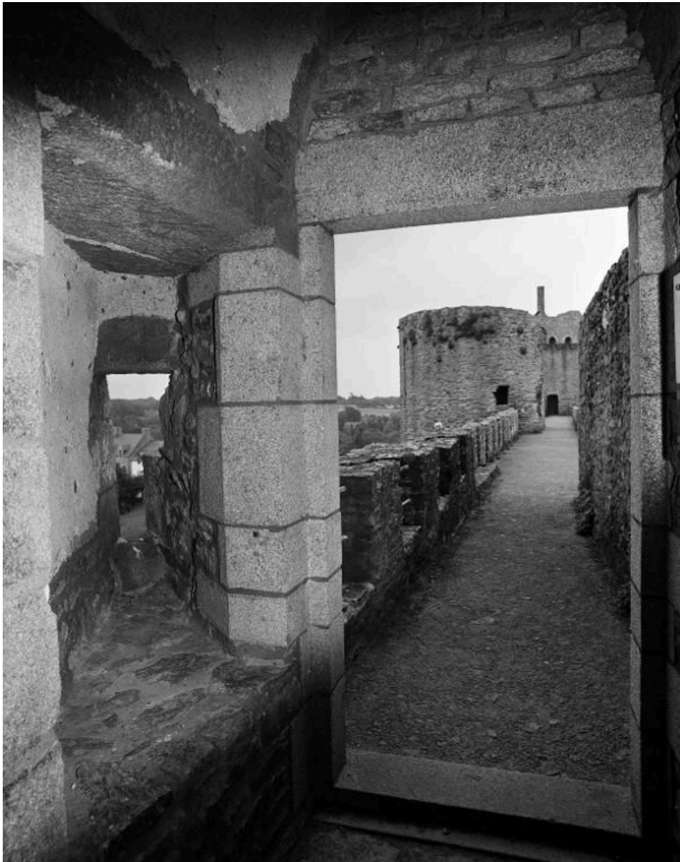
Château fort, cortine nord, vue vers l'est et fenêtre de tir.
