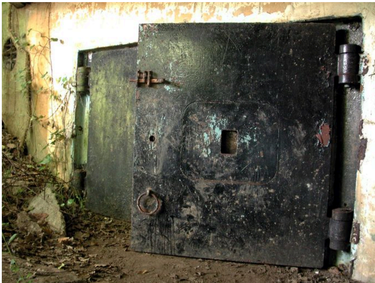
Vue de la porte blindée à deux battants de la chambre de combat (état en 2002)
