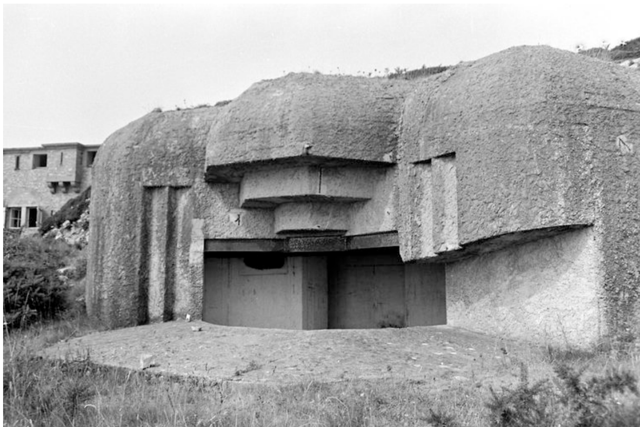
Vue du bunker - casemate de type 671 situé au nord : embrasure surmontée d'un front à redan dit Todt, 1969
