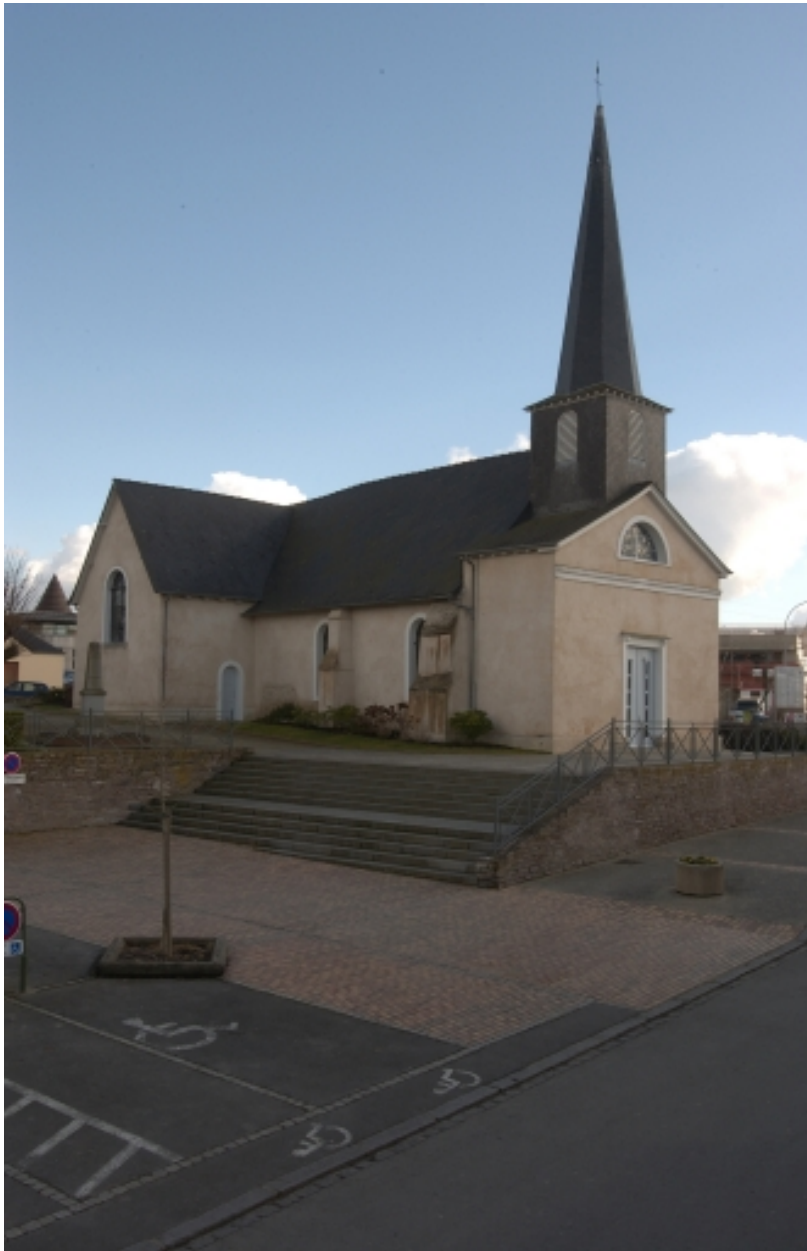
Elévation nord-est : vue générale
