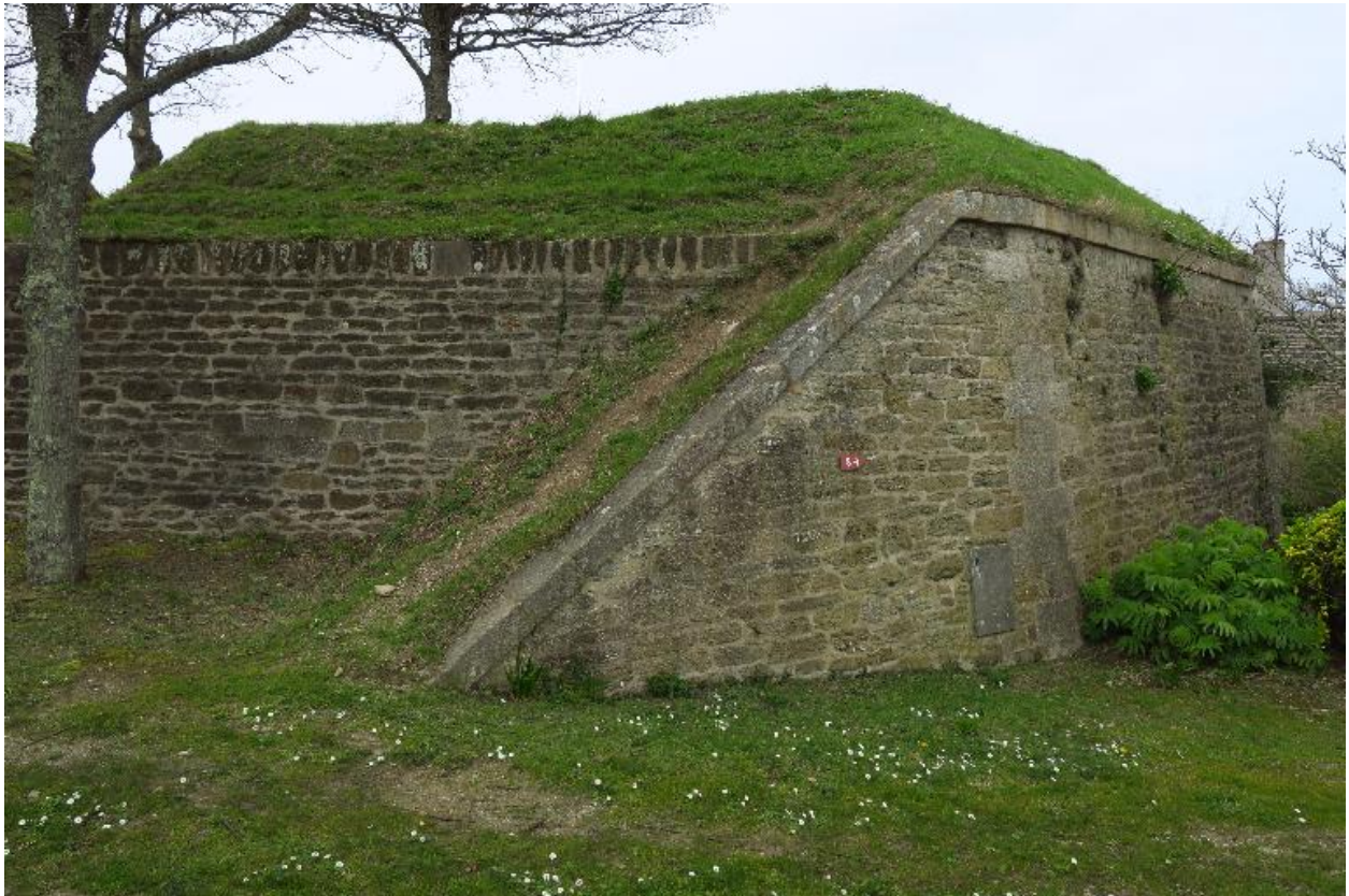
Le Palais, citadelle, cavalier du bastion 2, mur de soutènement des terrassements disparus et escarpe du 17 e siècle dégagée par les restaurations.
