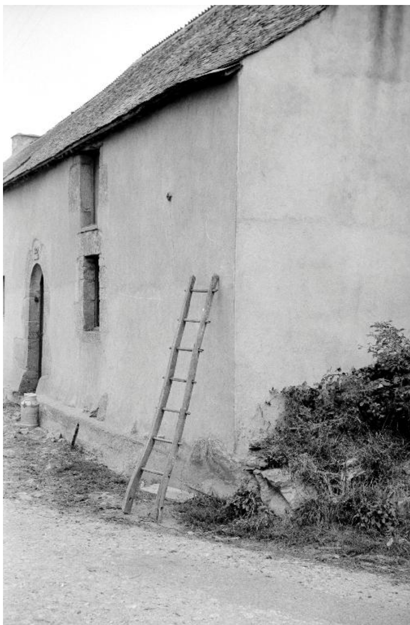
Ferme 19 (état en 1969)
