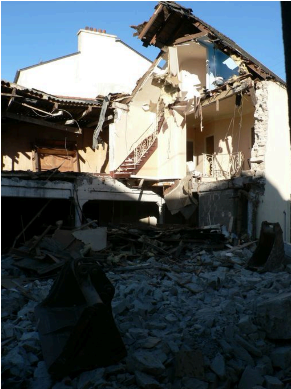
Démolition de l'ancienne conserverie de sardines Béziers (3 novembre 2006)
